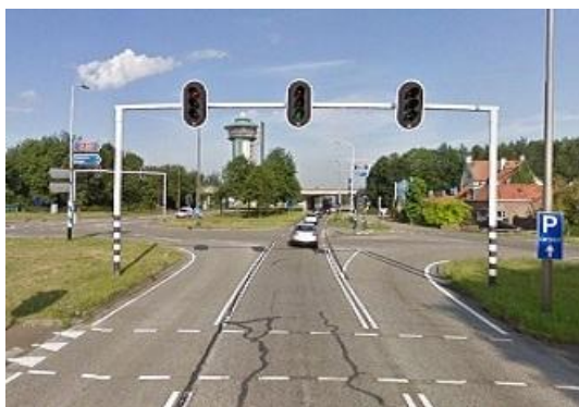
N377 voor de reconstructie, bron:Google streetview
