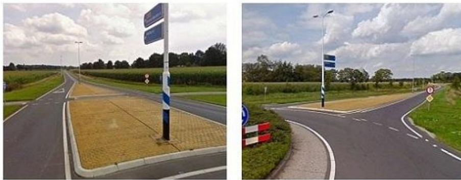
N332 Rondweg Heeten, bron: Google streetview
