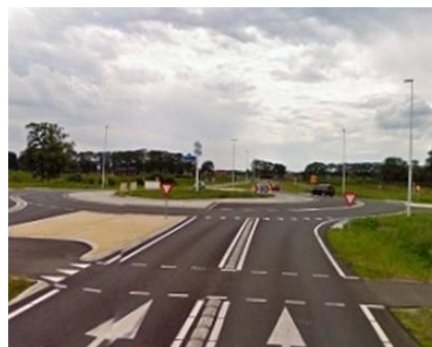
N348 Rondweg Wesepe, bron: Google streetview (2011)
